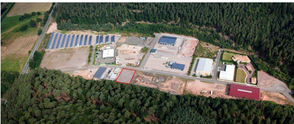
Luftaufnahme „Gewerbepark Neudahn 1“: H. Kröher (2013)
