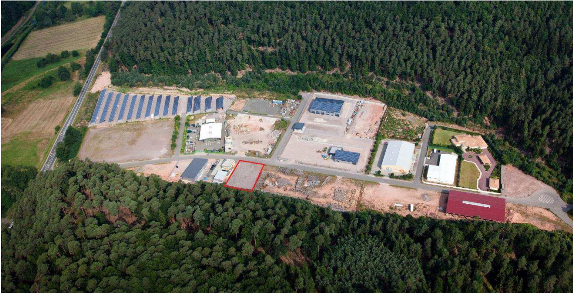
Luftaufnahme „Gewerbepark Neudahn 1“: H. Kröher (2013)
