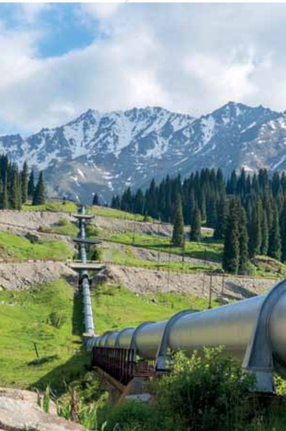
Pipeline bei Almaty, Kasachstan
