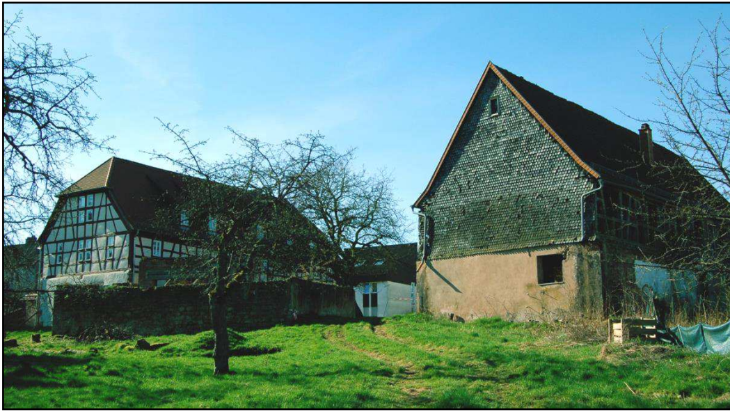
Ansicht von der Freifläche im rückwärtigen Bereich
